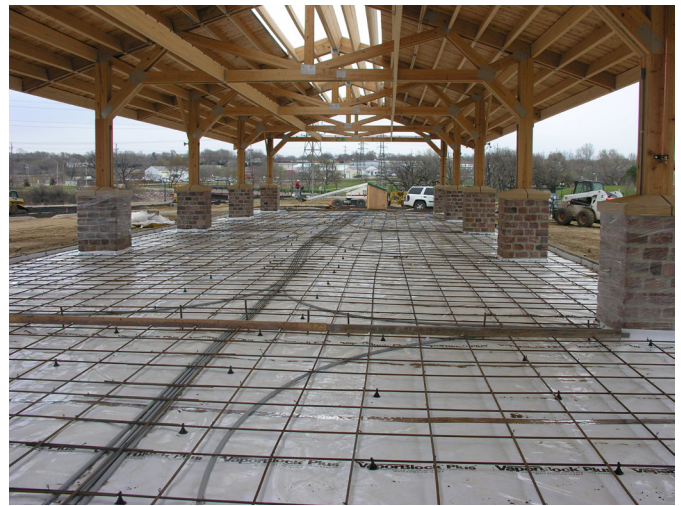
Under-Slab Vapor/Gas Retarder
